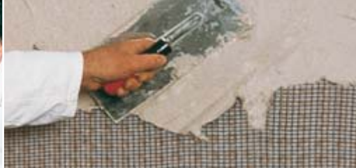
Putz einfach mit der Kelle aufziehen.
