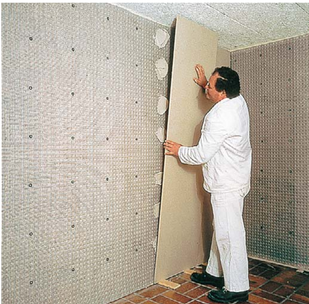
DELTA®-PT bildet eine wasserdichte und stabile Basis für Gips- und Kalkzementputz oder Gipskartonplatten.
