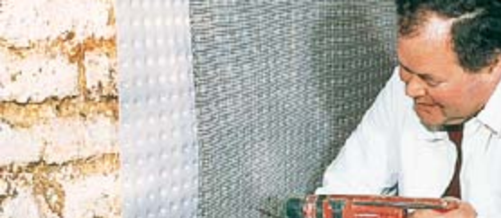
Leichte Befestigung auf der Wand.
