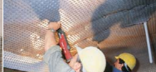
Im Tunnel dient DELTA®-PT als Träger für Spritzbeton.
