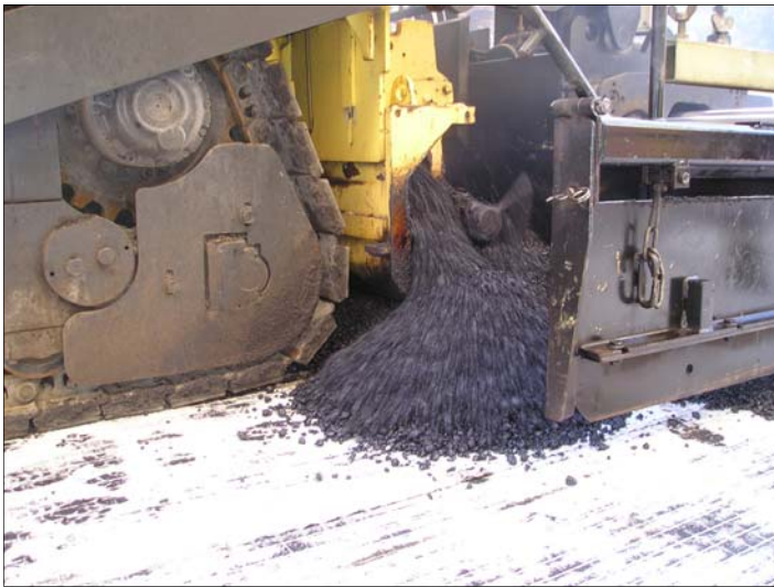
La máquina colocadora camina en el geocompuesto YaYa.tec® Glasofalt GS sin romperlo
